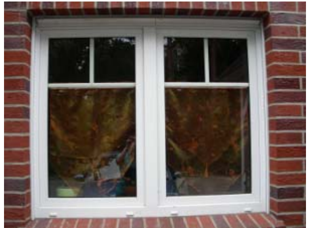
Abb. 3 Fensterprofil aus PVC
